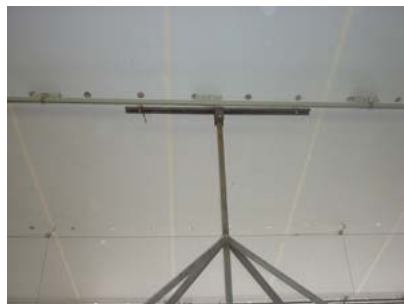
Des roulettes sont boulonnées à l'extrémité de l'armature et insérées dans le rail.
